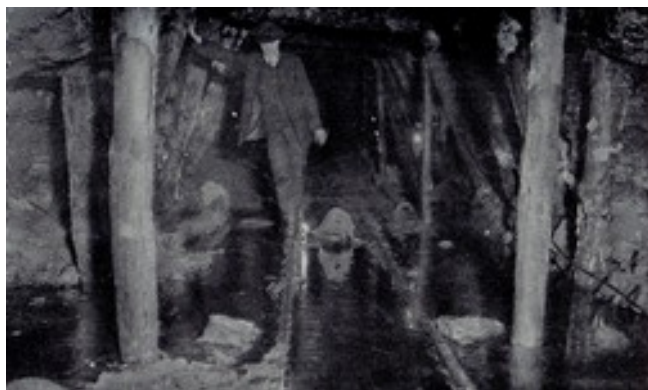
Figure 3: Infiltration de l'eau dans une mine abandonnée durant la grève des mineurs.
